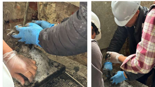
Figura 19. Vaciado de la mezcla
