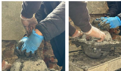
Figura 22. Seguimos con el vaciado de la mezcla
